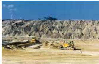
Sanierungsarbeiten am Klinger See im rückwärtigen Bereich des Tagebaus Jänschwalde, 1999
