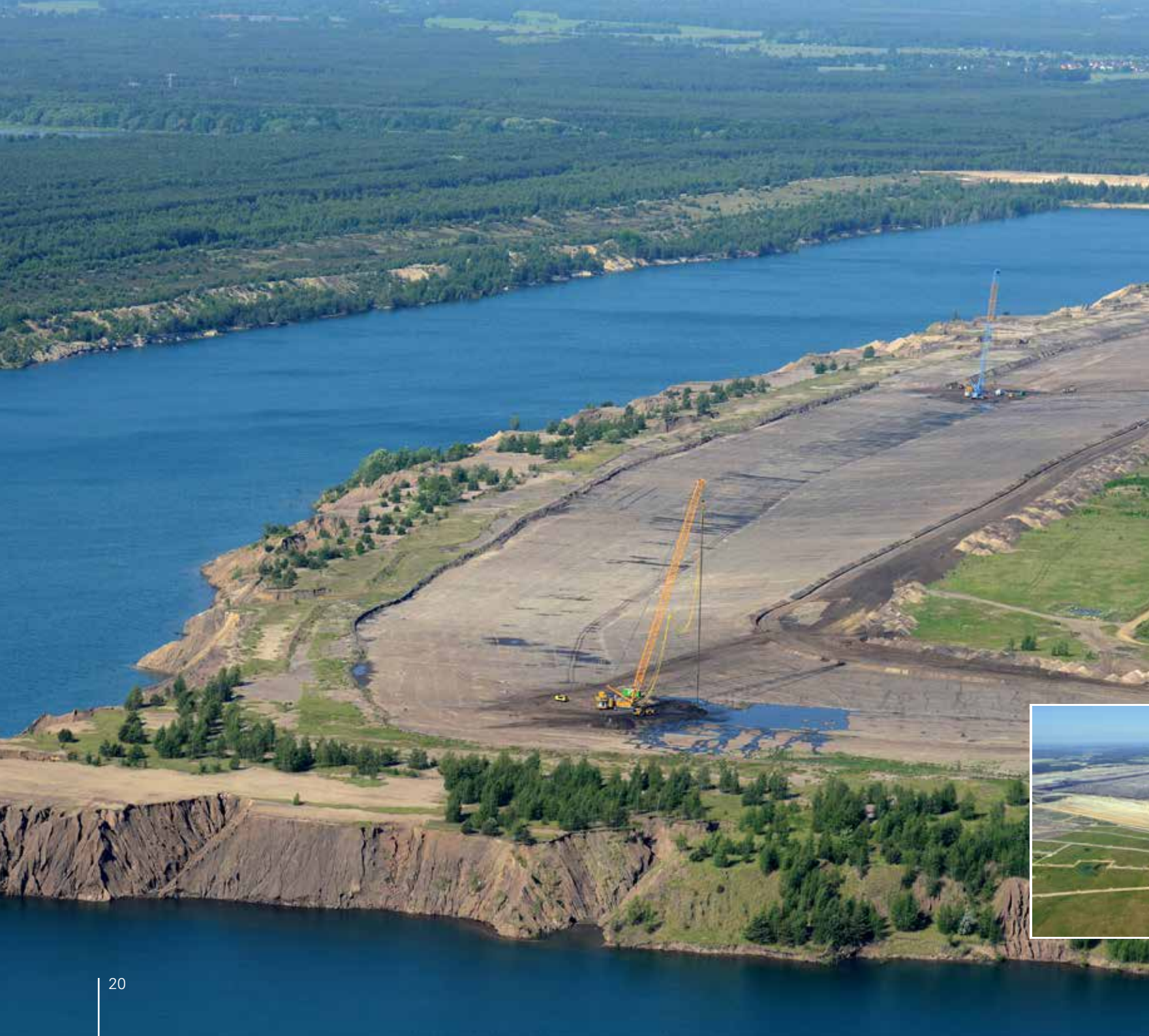
Rütteldruckverdichtung am Ufer des entstehenden Klinger Sees, 2014
