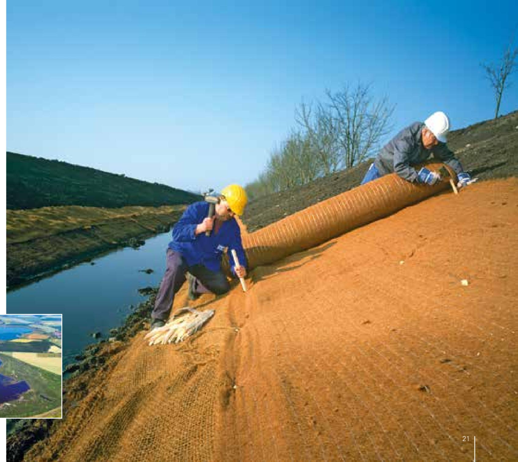
Sanierungsplanung für die Aufschlussmassen des ehemaligen Tagebaus Königsau sah für die Böschungsabschnitte der Halde 1 eine Kombination aus Bodenaustausch und dem Aufbau einer Anstützung am Fuß der Böschung sowie eine Kopffentlastung vor.
